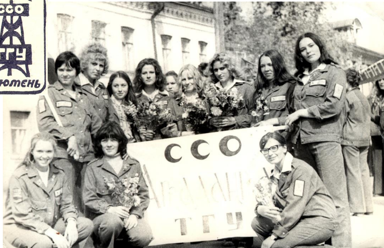
Студенческий строительный отряд «Атланта», 1975 г.
