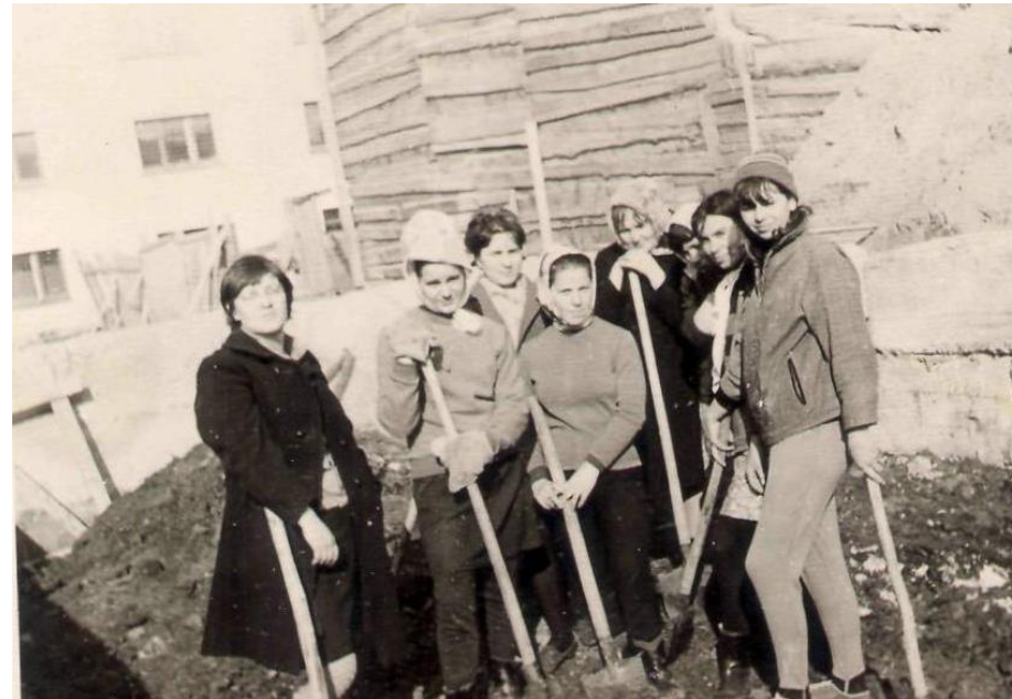
Студенты вуза на строительстве общежития по ул. Мельникайте
